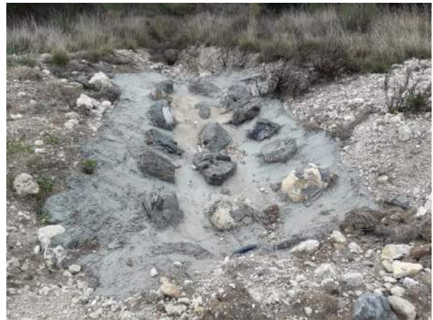
Photo 21 : Evacuation fossé longitudinal avec enrochements bétonnés (28/11/19)
