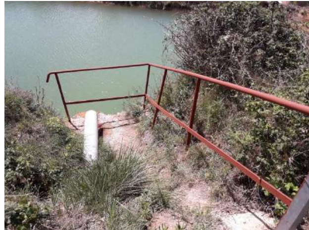
Photo 48 : Rampe de sécurité au drain central
