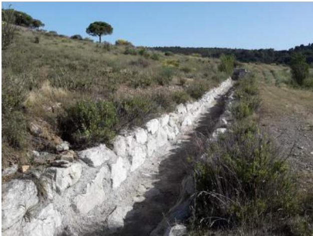
Photo 60 : Caniveau d'évacuation des eaux pluviales traversant le champ Magné (27/06/19)
