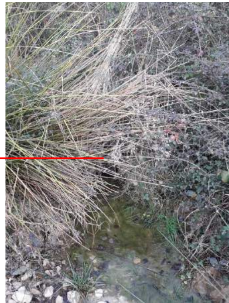
Photo 7 : Sortie du drain de pied du flanc est de Montredon (17/12/19)
