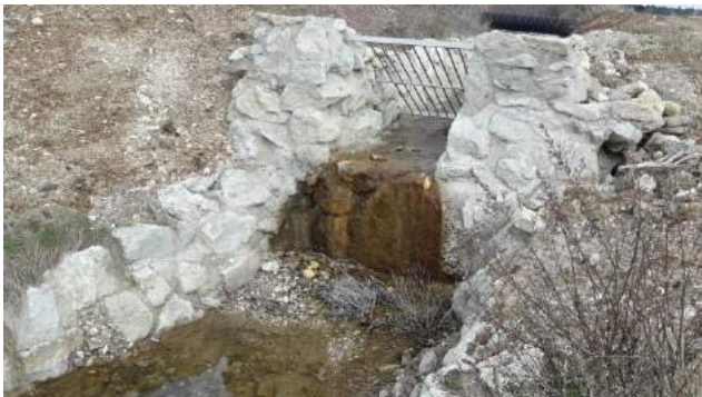
Photo 62 : Bassin de dissipation (18/02/19)
