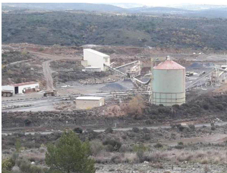
Photo 76 : Vue du site de la Caunette depuis le bassin de Montredon (28/11/19)
