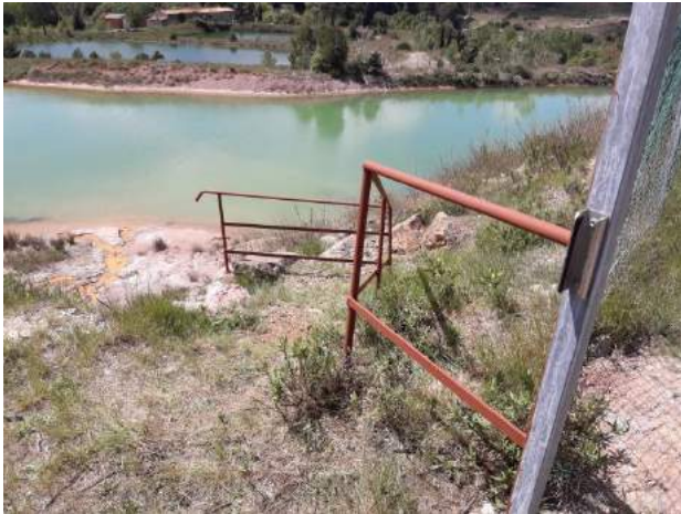
Photo 47 : Rampe de sécurité au drain Sud
