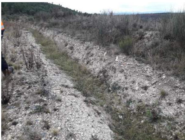
Photo 14 : Caniveau pluvial plateforme +248m NGF (28/11/19)
