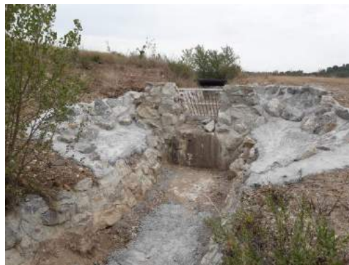
Photo 64 : Enrochement liaisonnés mis en place (27/08/19)
