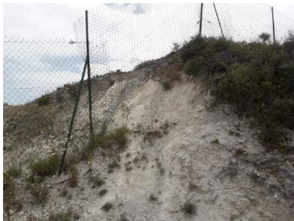
Photo 44 : Grillage soulevé avec passage au sol (25/06/19)
