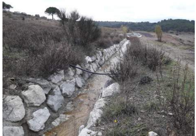
Photo 61 : Caniveau d'évacuation des eaux pluviales traversant le champ Magné (16/12/19)
