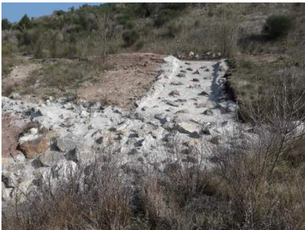
Photo 53 : Déversoir amont refait (25/03/19)
