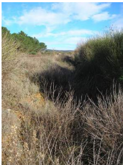
Photo 73 : Caniveau ceinturant le site (17/12/19)
