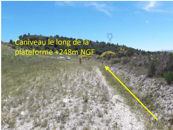
Photo 12 : Caniveau pluvial plateforme +248m NGF (17/06/19)
