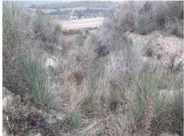
Photo 17 : Exutoire du caniveau de la plateforme +248m (28/11/19)
