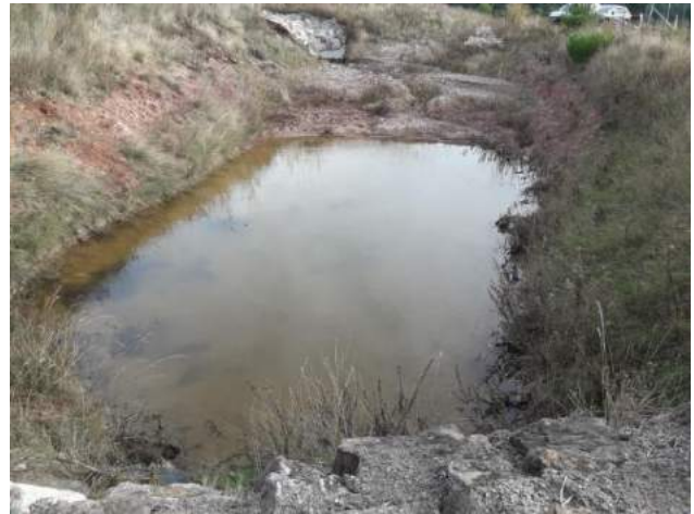
Photo 52 : Bassin de dissipation d'énergie vue depuis le déversoir aval (12/12/18)
