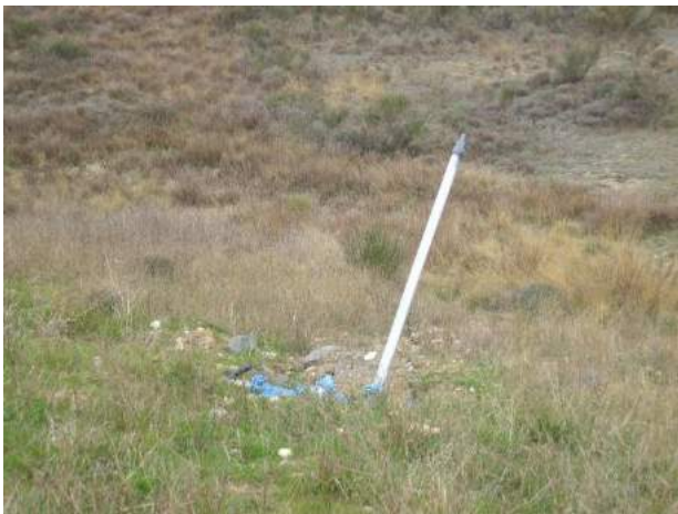
Photo 5 : Départ du drain D2 à Montredon
