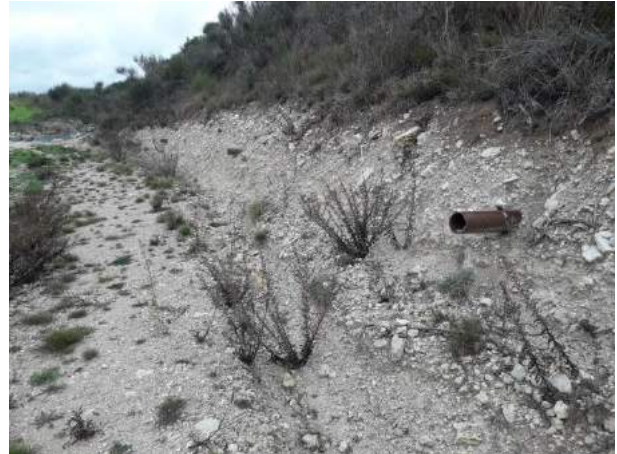
Photo 19 : Drains horizontaux en partie inférieure du talus aval – vue vers l'ouest (28/11/19)
