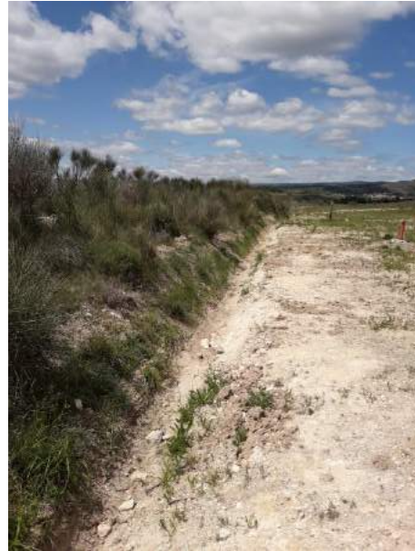
Photo 13 : Caniveau de pluvial sur plateforme +249m nettoyé (29/04/19)
