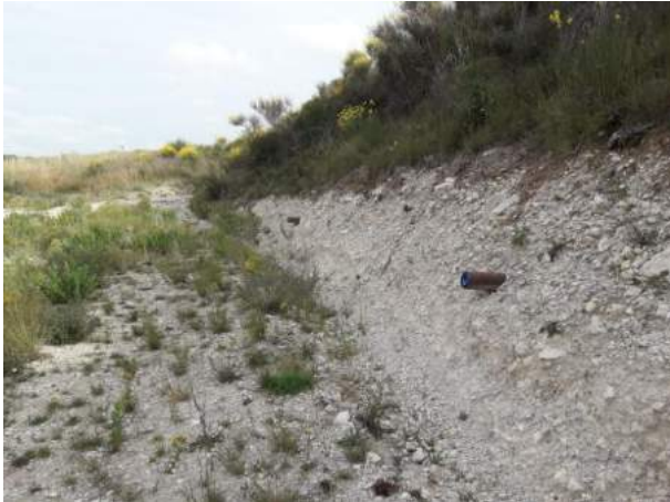
Photo 18 : Drains horizontaux en partie inférieure du talus aval – vue vers l'ouest (25/06/19)
